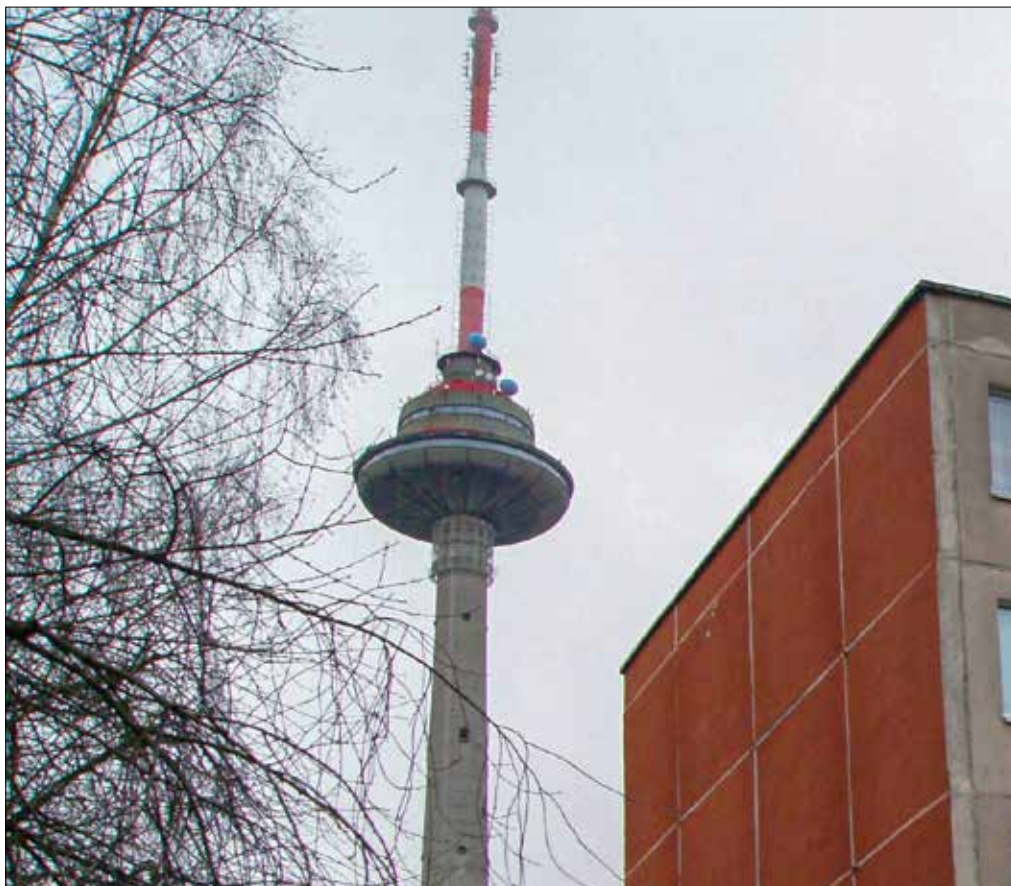
Wileńska wieża telewizyjna, zbudowana 40 lat temu, jest przygotowywana do rekonstrukcji Fot. Marian Paluszkiewicz
